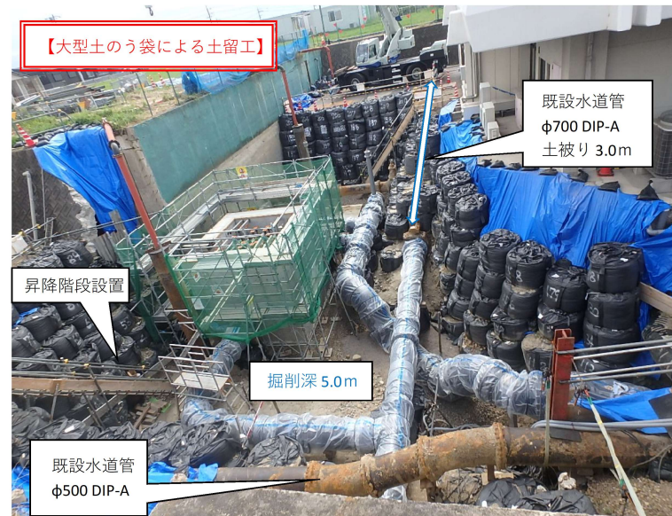
\phi 600 mmDIP-NS布設 ・ 緊急遮断弁設置 （路線7 \phi 600 mmDIP-NS布設路線）
