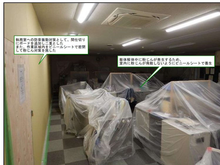
衛生管理【内部 粉じん対策養生】
