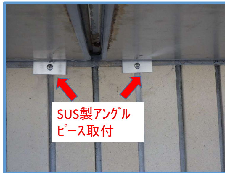
金属製庇の下地部材の補強
