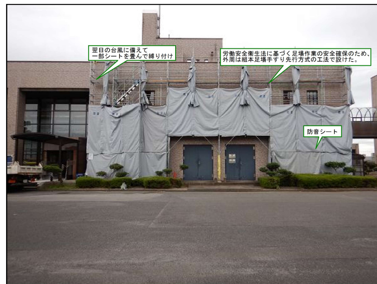
安全管理【管理棟北面 足場仮設、養生】
