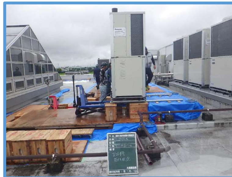
搬入ステージからの機器の搬入
